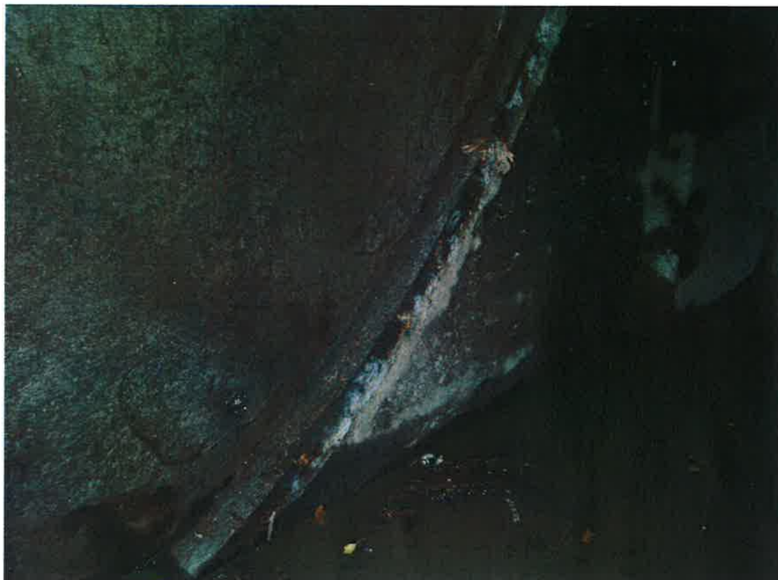
Dosedací plocha bočního těsnění segmentového uzávěru
